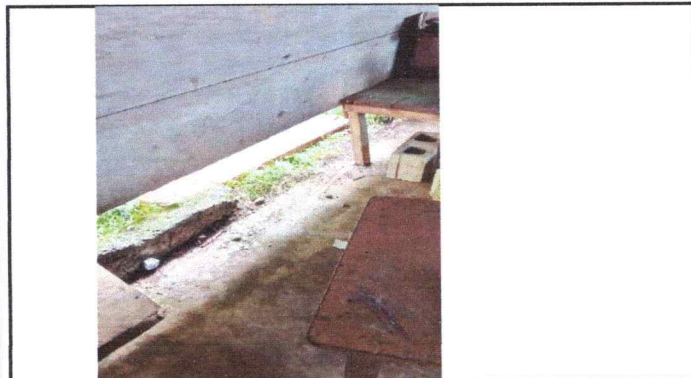
Foto No. 3 se Observa espacios descubiertos en pared de madera en el establecimiento
